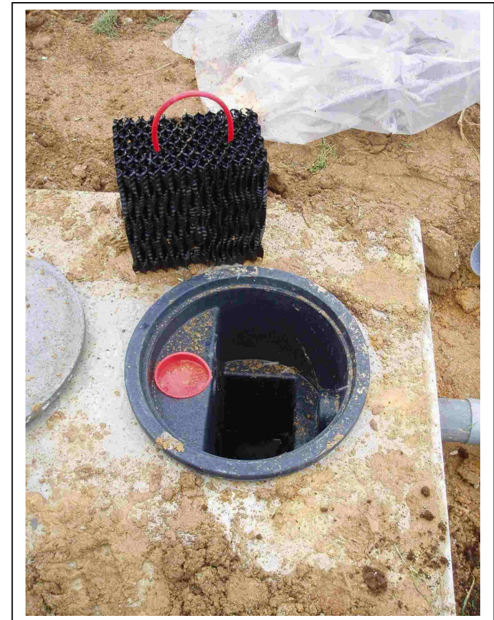
Préfiltre en plastique alvéolaire (structure de nid d'abeilles)
